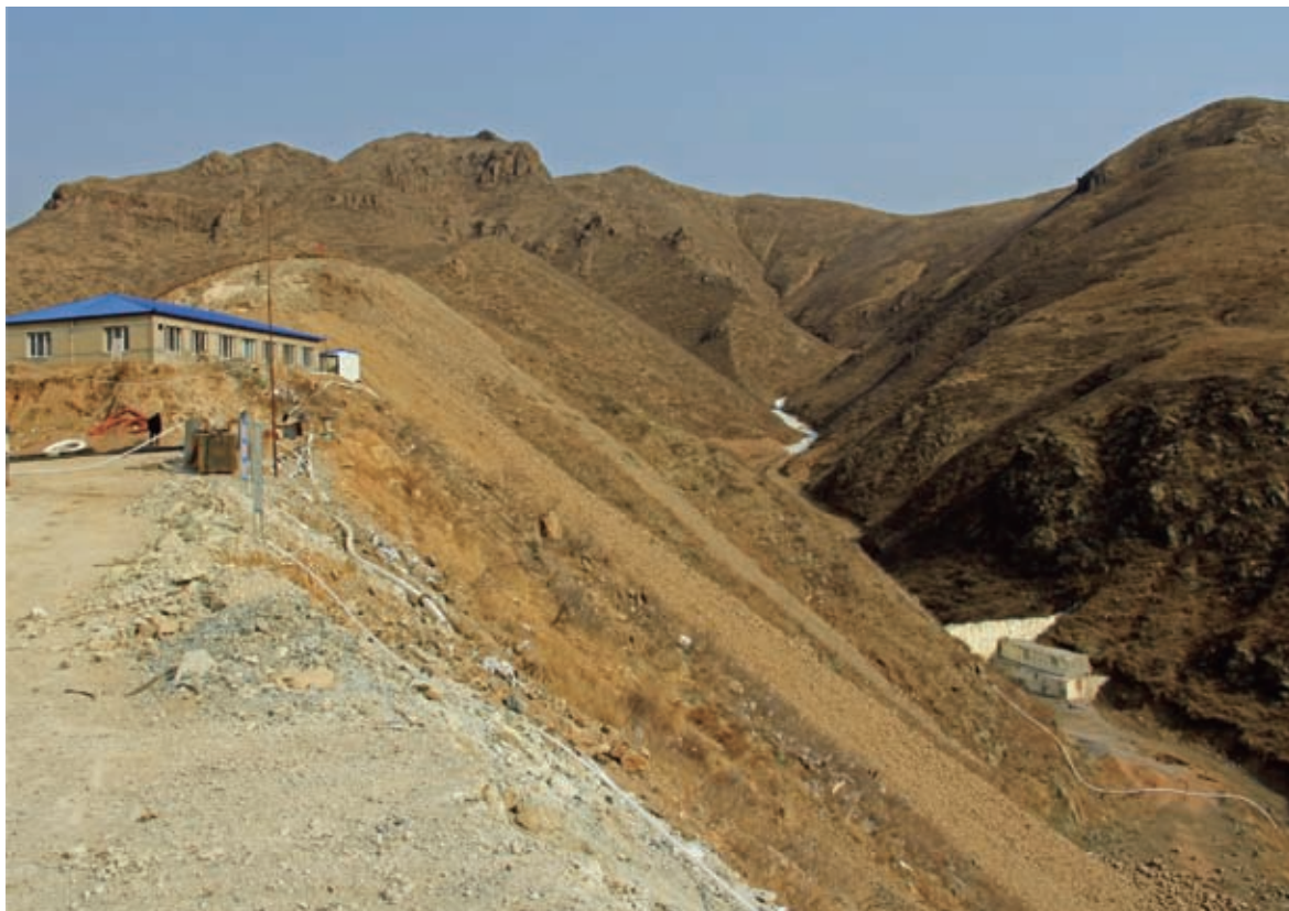
圖四－敖漢旗乾排尾礦庫的建設
